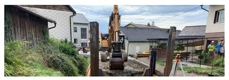
Die Bauarbeiten für die Querung der Pergerstraße und Bahn haben bereits begonnen. Ab 7. September ist der Mühlenweg für zwei Monate gesperrt, weil dann dort das Ausleitungsrohr verlegt wird und Gartenmauern abgerissen werden.
