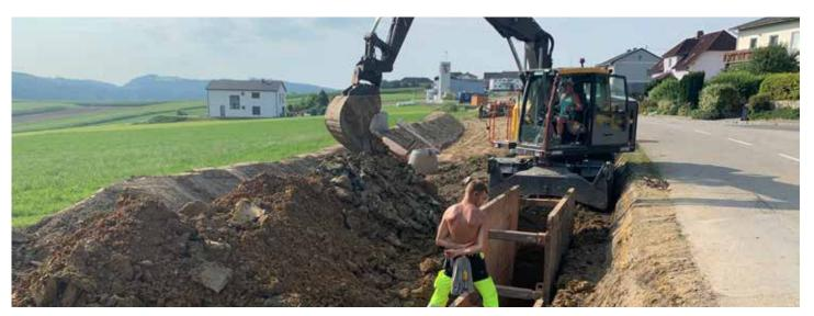
Vom Rückhaltebecken wurde im Sommer bis zum FF-Zeughaus Winden/Windegg ein neuer Regenwasserkanal errichtet
