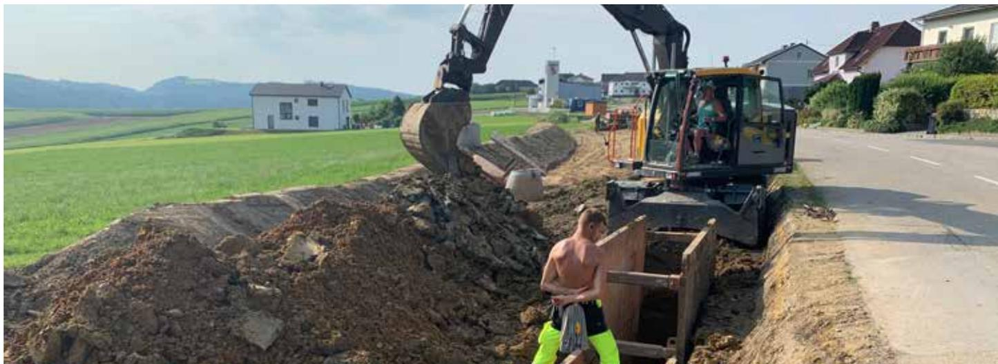
Vom Rückhaltebecken wurde im Sommer bis zum FF-Zeughaus Winden/Windegg ein neuer Regenwasserkanal errichtet
