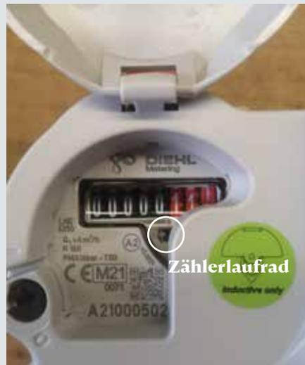
Das am Bild markierte Zählerlaufrad darf nicht laufen, wenn gerade kein Wasser verbraucht wird!
