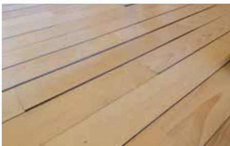
Der Boden in den Büroräumlichkeiten wurde durch die Feuchtigkeitsprobleme stark beschädigt!
