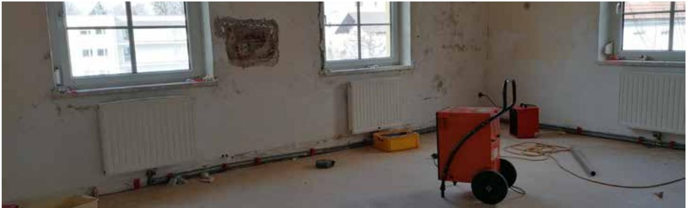
Der alte Turnsaal während der Renovierung. Das alte Mauerwerk sorgte für Probleme mit Schimmel und Feuchtigkeit.
