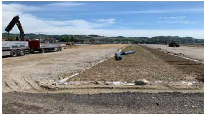
Die erweiterten Stellflächen von HÖDLMAYR müssen in 25 Jahren wieder rückgebaut werden. Der Ackerboden wird mit einem Flies bedeckt und „konserviert“, damit sich der Schotter (Unterbau für eine Asphaltdecke) nicht mit der Ackererde mischt
