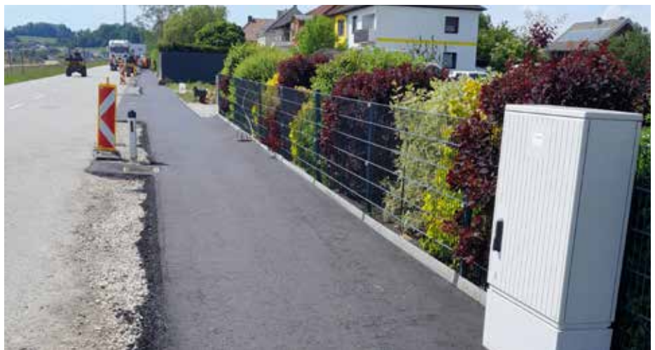
Kosten in der Höhe von EUR 40.000,- für die Gehsteigsanierung und Breitbandausbau haben sich die Fa. Liwest und die Gemeinde Schwertberg geteilt.
