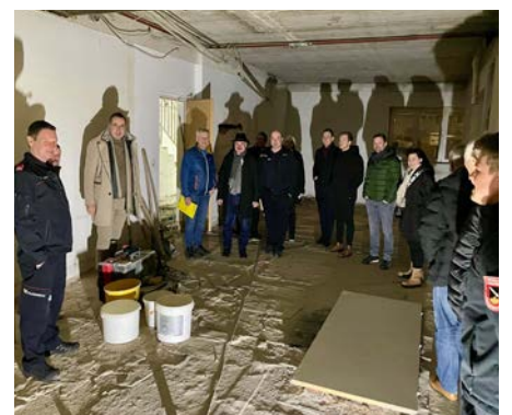
Gemeinsamer Lokalausgleich des Gemeinderates mit der FF Schwertberg und Besichtigung der Baustelle nach dem Sondergemeinderat
