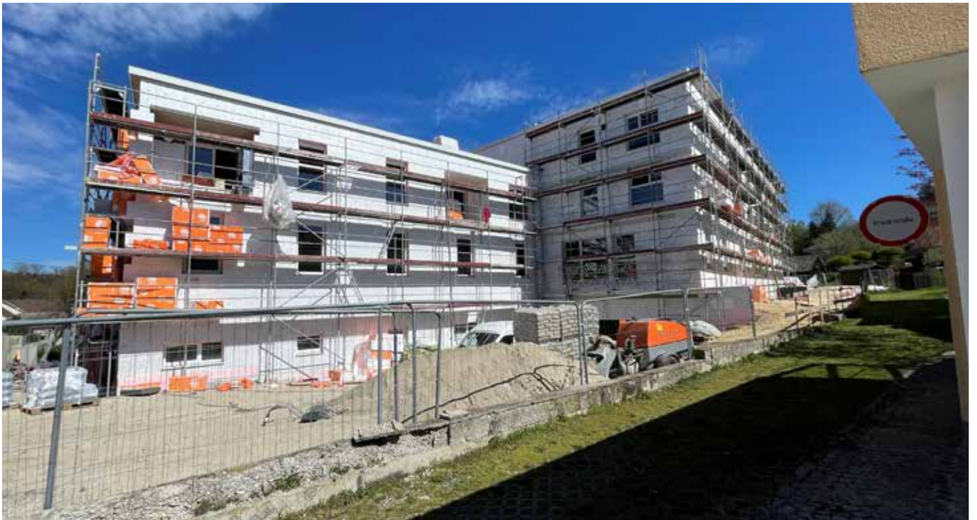
Die Außenfassade des Gesundheitszentrums nimmt Gestalt an
