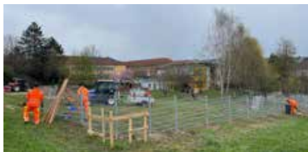
Der Zaun wurde durch die Bauhofmitarbeiter aufgestellt
