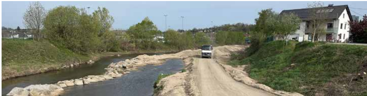
Seit Jänner wurden unzählige Tonnen an Sand abtransportiert
