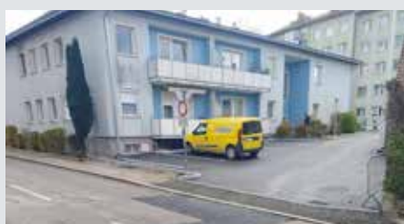
Die neu asphaltierte Zufahrt Schacherbergstraße.
