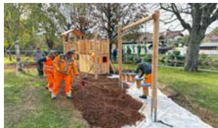
Der Kletterturm wurde von unseren Bauhof-Mitarbeitern für die Schwertberger Kinder aufgestellt.
