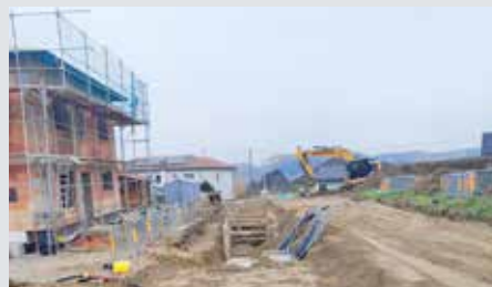
Umfangreiche Bauarbeiten sind notwendig, um die sieben Bauparzellen fachgerecht anzuschließen.
