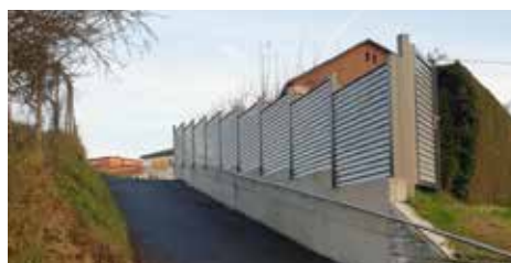
Der Handlauf beim Friedhofsweg wurde montiert.
