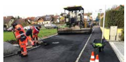
Großbaustelle Stelzhammerstraße bald fertig.
