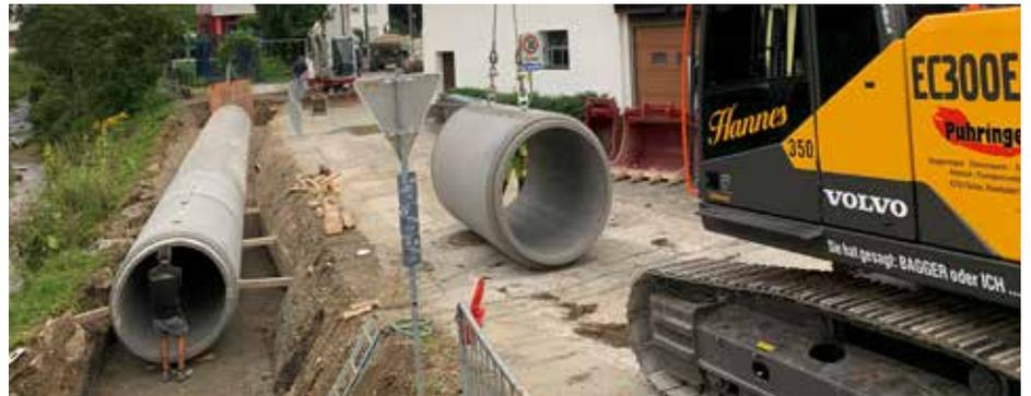
Am 17. August wurden die Betonrohre für den Rückstaukanal von einem 30-Tonnen Bagger verlegt.
